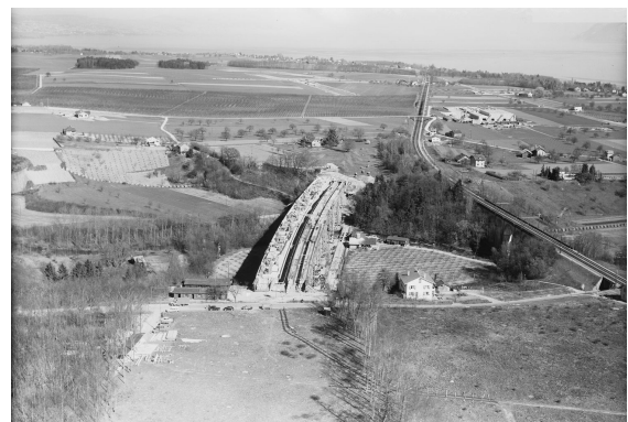
Pont sur l'Aubonne, N1 en construction 1962
